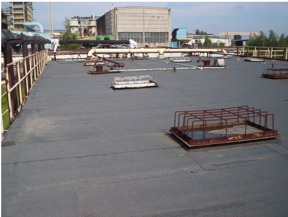
Rys. 7. Nowe przekrycie osadnika po wykonanej naprawie.
