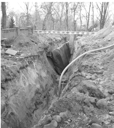
Rys 8. Budowa styropianowego ekranu izolującego
