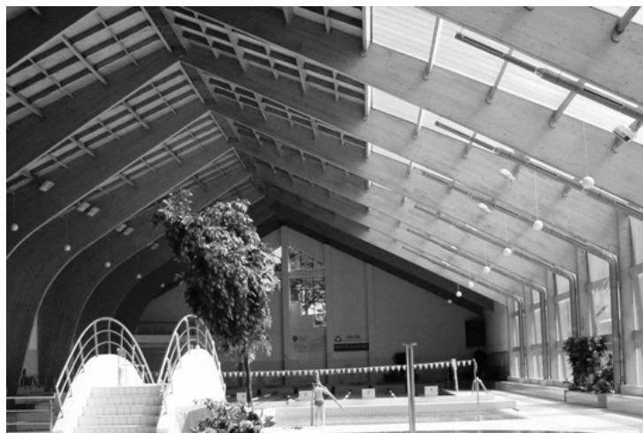
Rys 3. Widok konstrukcji wewnątrz hali basenów
