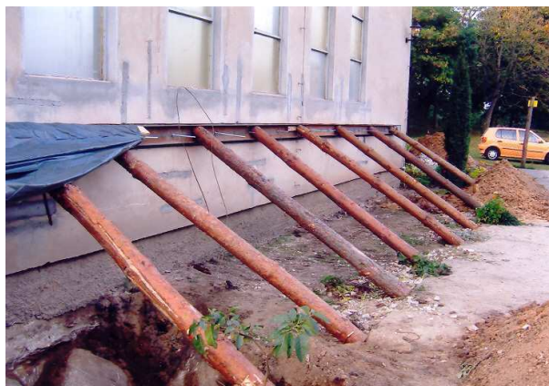
Rys. 9. Widok konstrukcji odciążającej.
