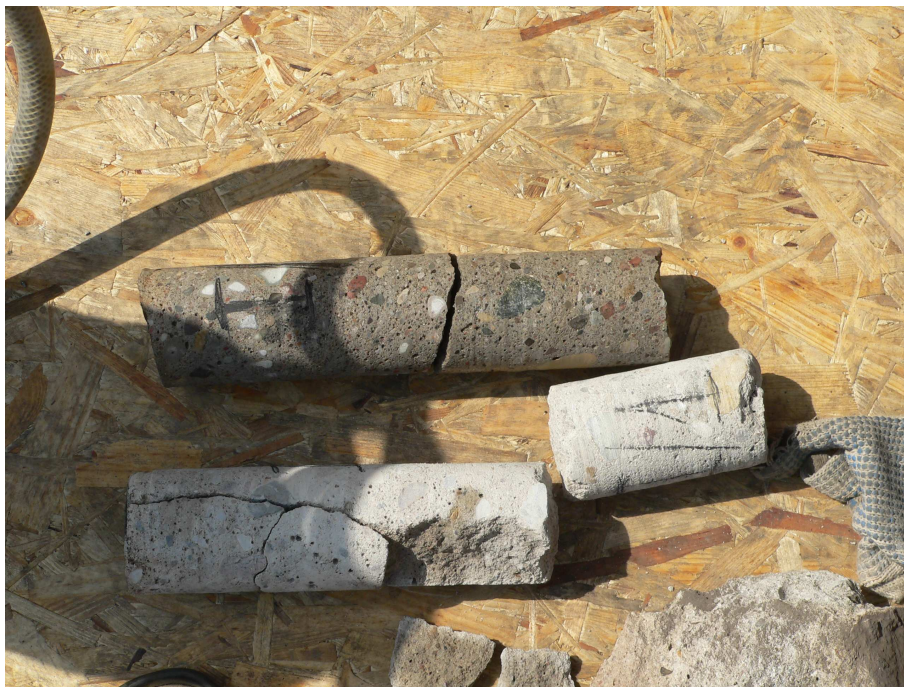
Rys.5. Widok odwiertów próbek do badań laboratoryjnych pobrane z belek rusztu i słupów ram
