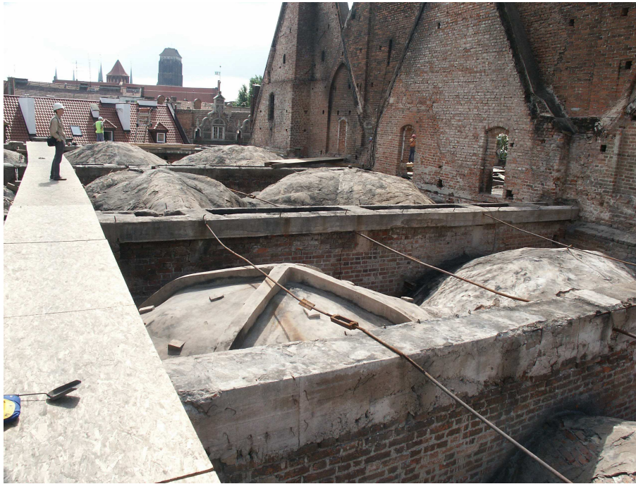
Rys.7. Widok wieńców i ściągow stalowych nad prezbiterium
