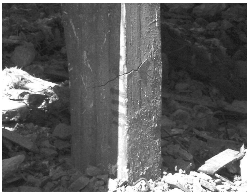
Rys. 6. Tworzenie się w słupie przegubu plastycznego
