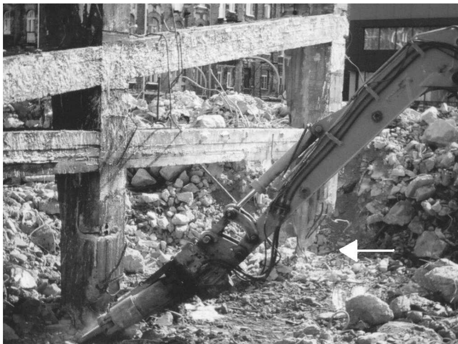
Rys. 5. Zmiazdżony dolny fragment skrajnego słupa
