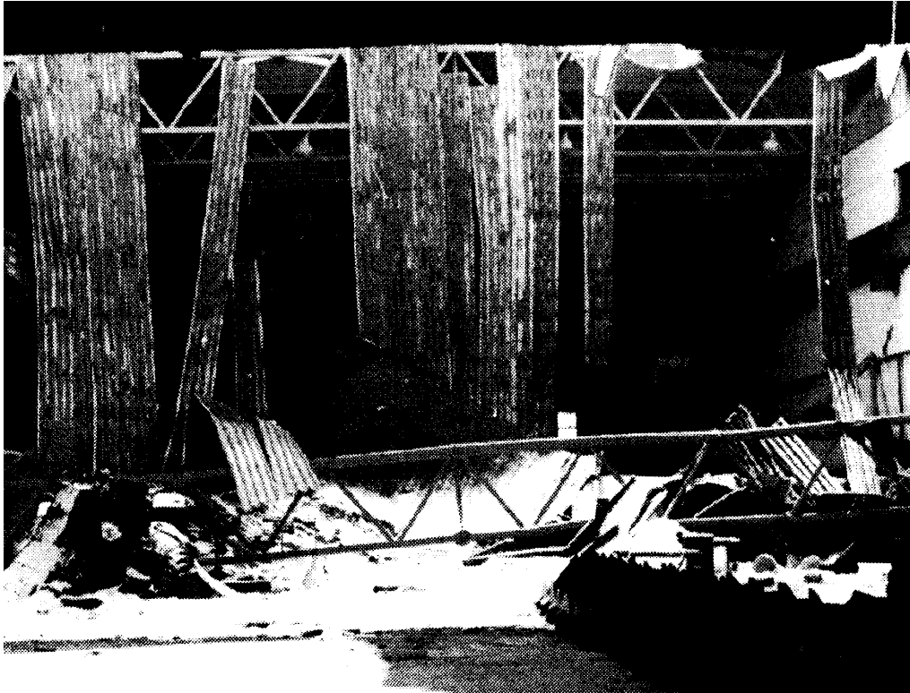
Rys.1. Widok hali przemysłowej we Lwowie po katastrofie konstrukcji dachu
