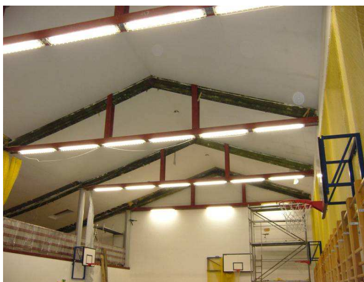
Rys. 1. Widok hali oraz otworów wywiewnych w kalenicy
