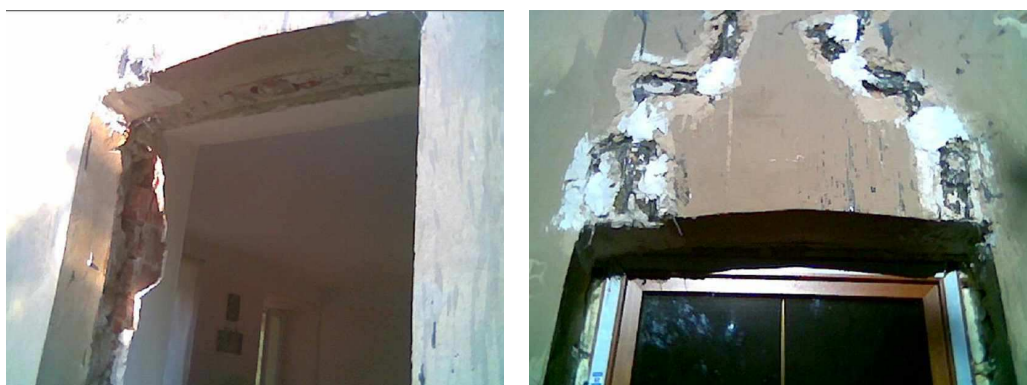
Rys.5. Widok naprawionego fragmentu południowej ściany szczytowej w trakcie i po wymianie okna
