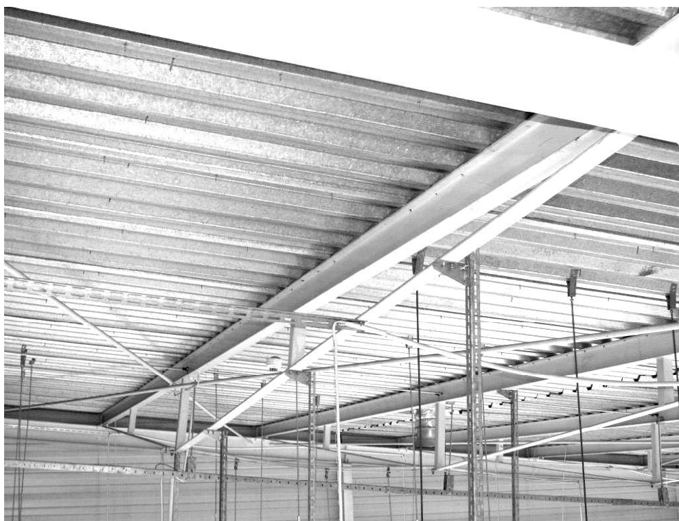
Rys. 3. Widok konstrukcji płatwi wzmocnionych cięgnem z płaskownika.
