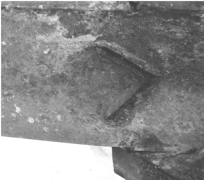
Rys. 4 Ślad spawanego połączenia słupka z pasem dolnym kratownicy.
