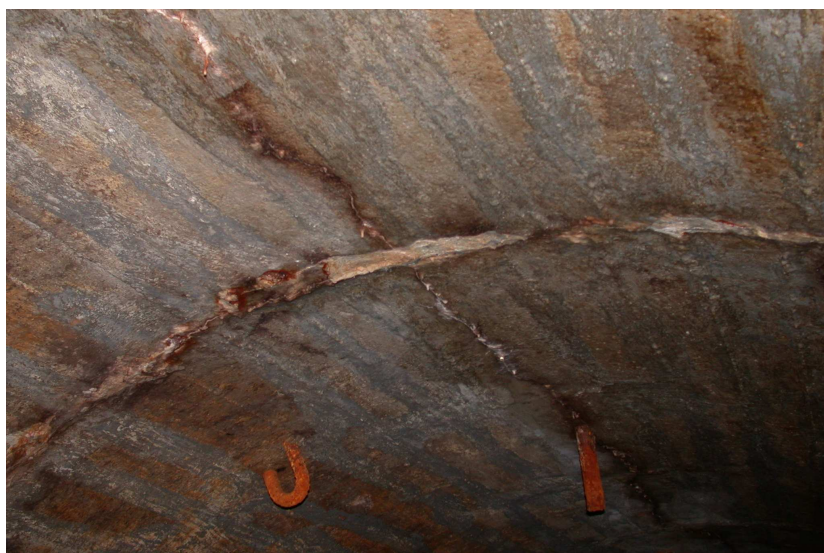
Rys. 3 Uszkodzenia tuneli – rysy wzdłużne w kluczu: a) widok ogólny, b) detal
