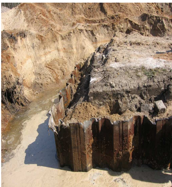
Rys. 4. Rozbiórki starych fundamentów
