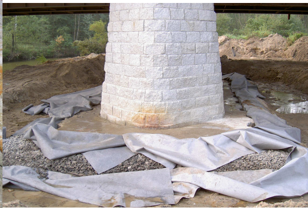
Rys. 8. Uszczelnienie wewnątrz ścianki; podpora nr 2 Rys. 9. Drenaż powierzchniowy przy podporze nr 2
