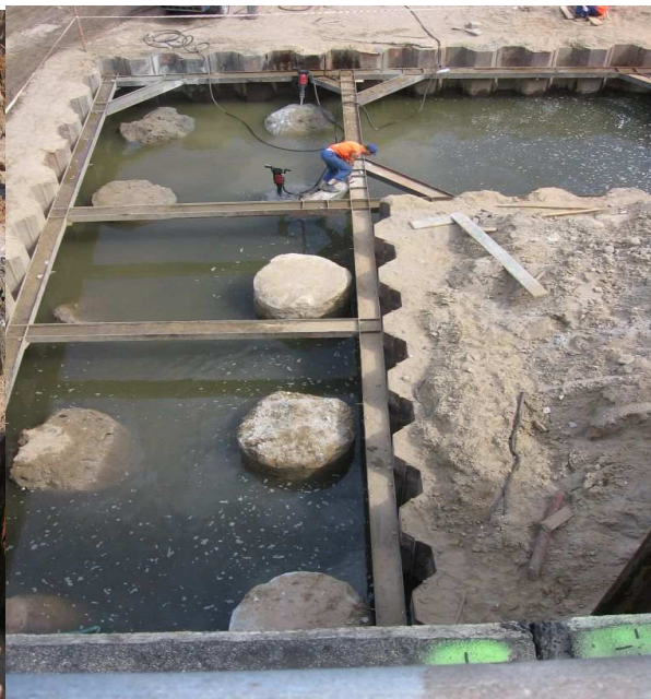
Rys. 5. Pale wewnątrz stalowej ścianki szczelnej
