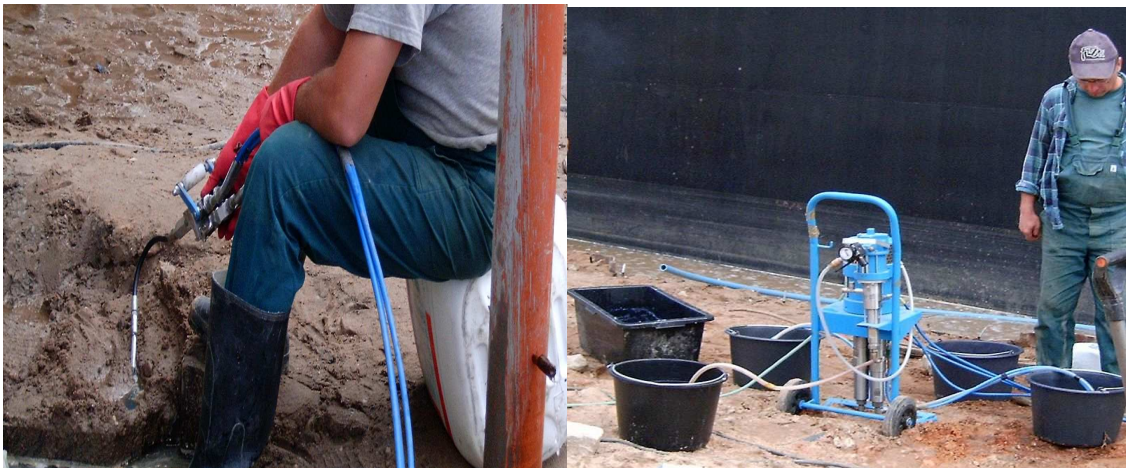
Rys. 6 i 7. Iniekcja gruntowa pompą dwukomponentową; podpora 3
