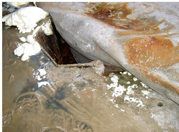
Rys. 8. Uszczelnienie wewnątrz ścianki; podpora nr 2 Rys. 9. Drenaż powierzchniowy przy podporze nr 2
