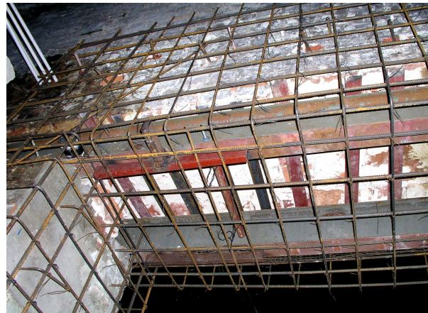
Rys. 11. Zbrojenie ramy wzmocniającej
