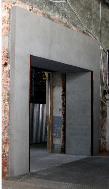
Rys. 14. Widok wzmocnienia – żelbetowego portalu
