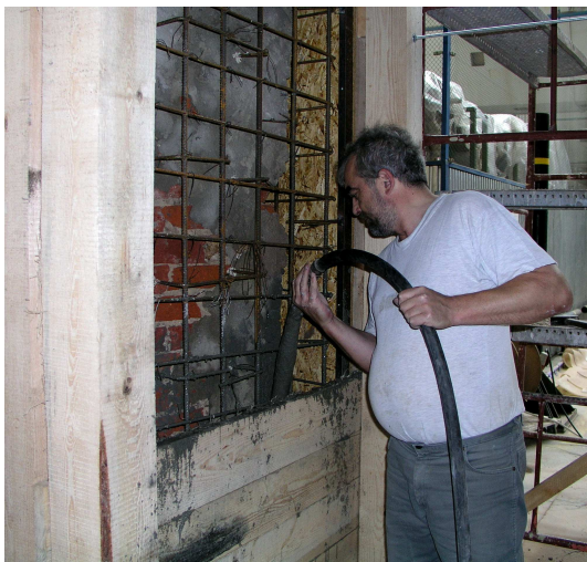
Rys. 12. Betonowanie pionowych elementów ościeznicy
