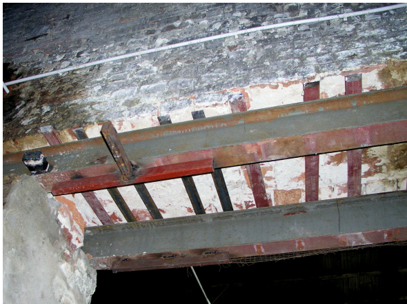
Rys. 10. Zabezpieczenie nadproża na czas prowadzenia robót wzmocniających
