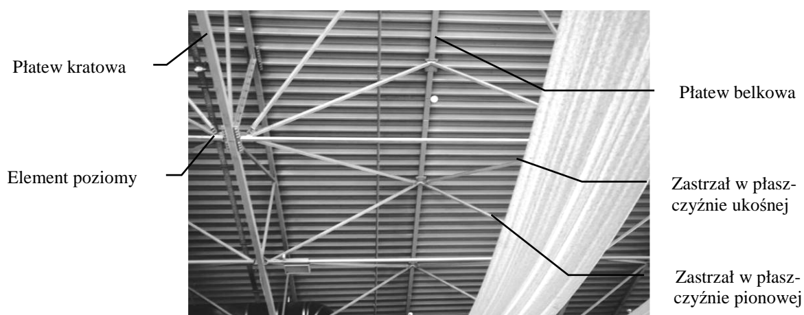
Rys. 1. Widok na płatwie dachowe i zastrzały
