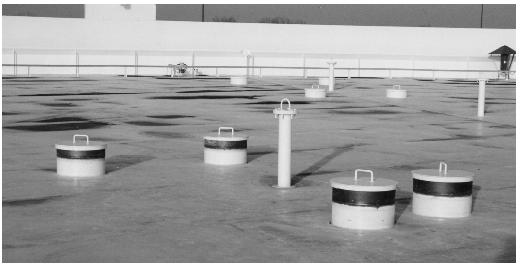
Rys. 11. Podwyższone króćce włazów do komór dachu pływającego
