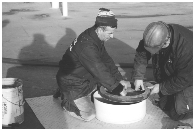
Rys. 9. Konstrukcja stalowej zaślepki włazu do komory
