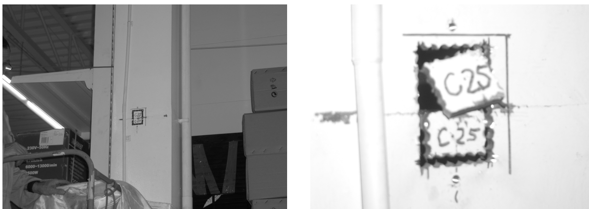
Rys. 4. Widoczny trzon z pobranym materiałem do badań.
