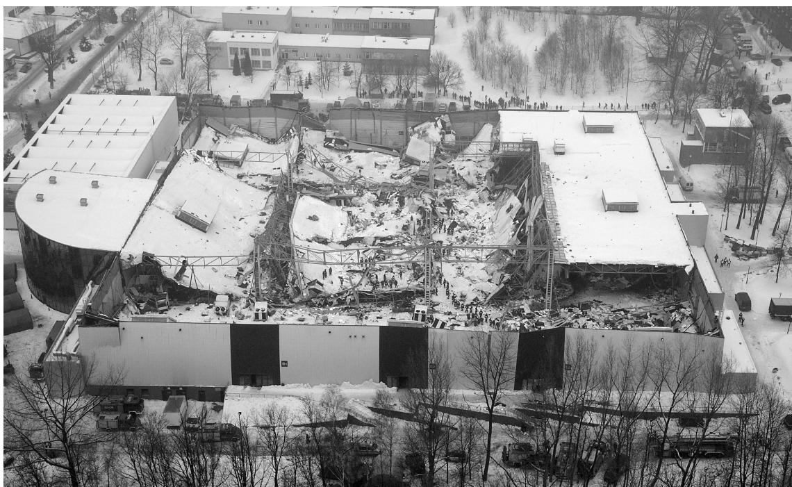
Rys. 8. Ogólny widok obiektu po katastrofie w dniu 28.01.2006 r.
