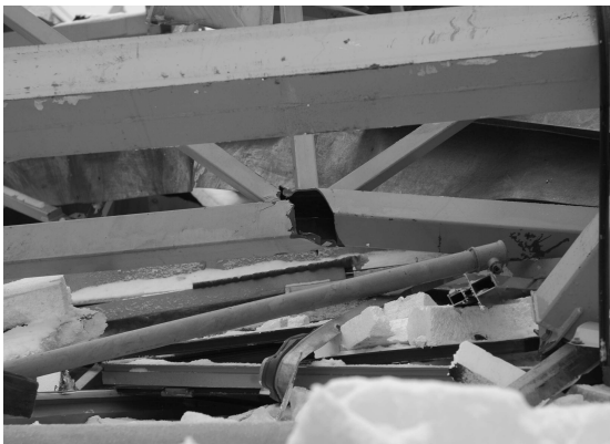
Rys. 14. Uszkodzenia płatwi a) pas dolny płatwi K1-2, b) styk montażowy płatwi
