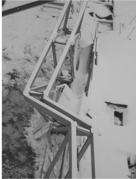
Rys. 13. Deformacje złamanych pasów podciągów a) K6 i b) K5
