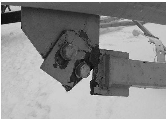
Rys. 17. Podstawowe formy zniszczenia połączeń zastrzałów z kratowymi płatwiami
