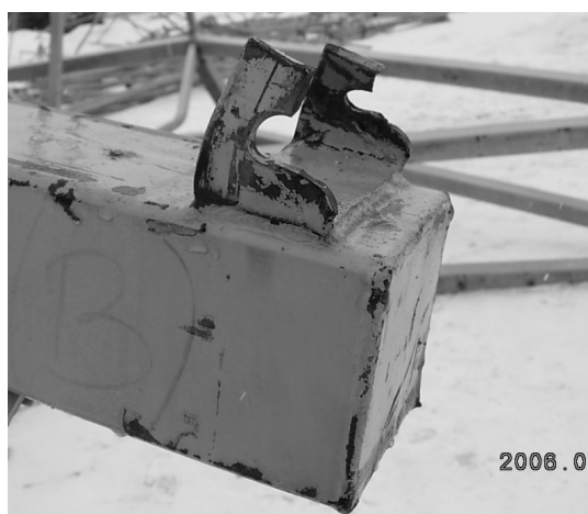
Rys. 10. Rozerwanie blach łączących głowicę płatwi z gniazdam podciągu
