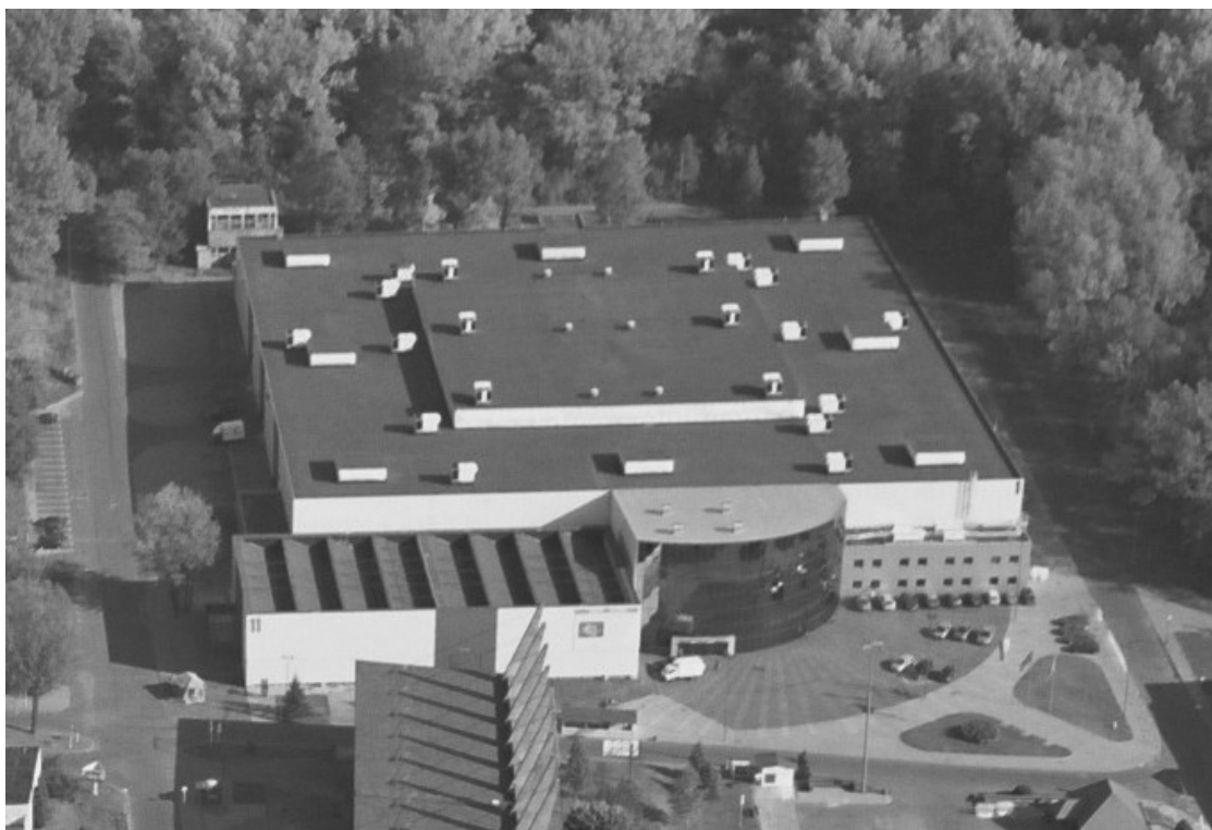
Rys. 1. Widok obiektu przed katastrofą
