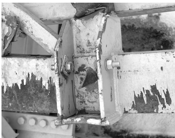
Rys. 10. Rozerwanie blach łączących głowicę płatwi z gniazdam podciągu
