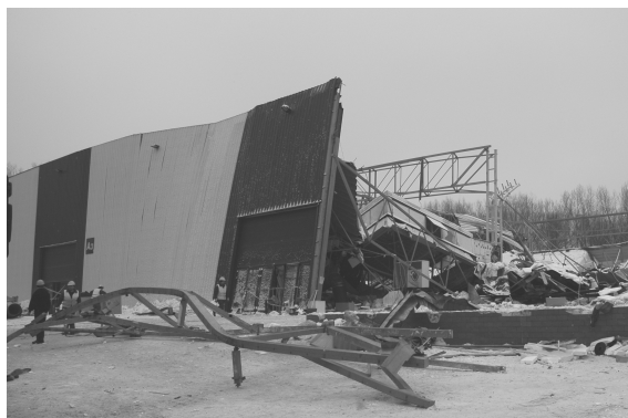
a) Ściana północna w osi A
