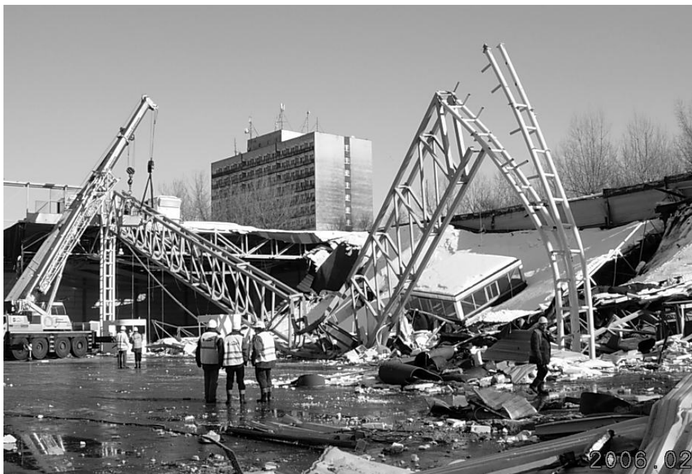
Rys. 11. Uszkodzenie słupa głównego S6
