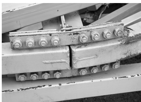
Rys. 14. Uszkodzenia płatwi a) pas dolny płatwi K1-2, b) styk montażowy płatwi
