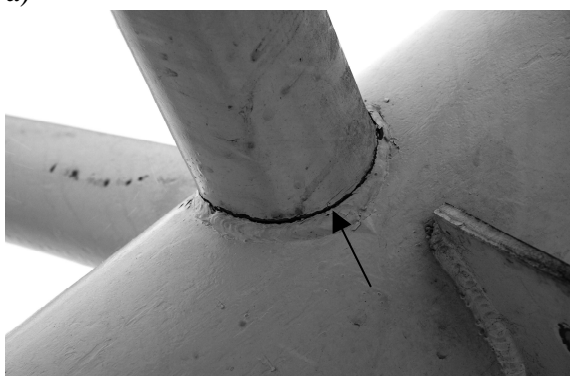
Rys. 11. Uszkodzenie słupa głównego S6
