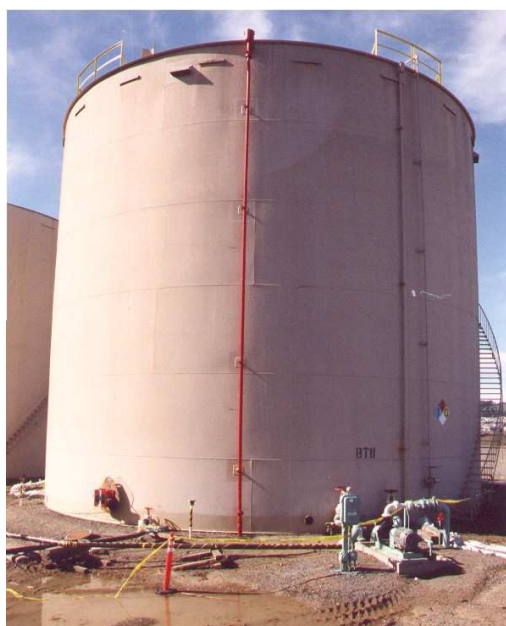
Rys. 5 Zbiornik benzyny przystosowany do przechowywania etanolu.
