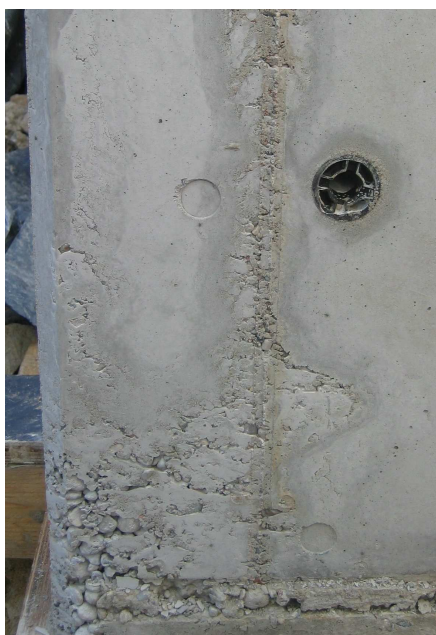
Rys. 4. Odbarwienia powstałe wskutek miejscowej zmiany w/c i „gniazda żwirowe”
