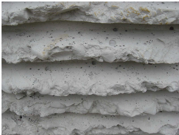
Rys. 3. Problem z odpowietrzeniem przy poziomym głębokim faktowaniu matrycy
