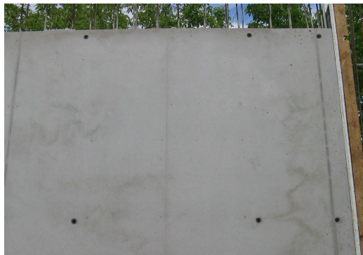
Rys. 1. Efekt nierównomiernego nanoszenia środka antyadhezyjnego
