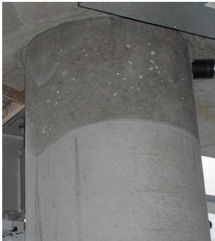
Rys. 2. Zmiany barwy wynikające z różnego czasu rozdeskowania
