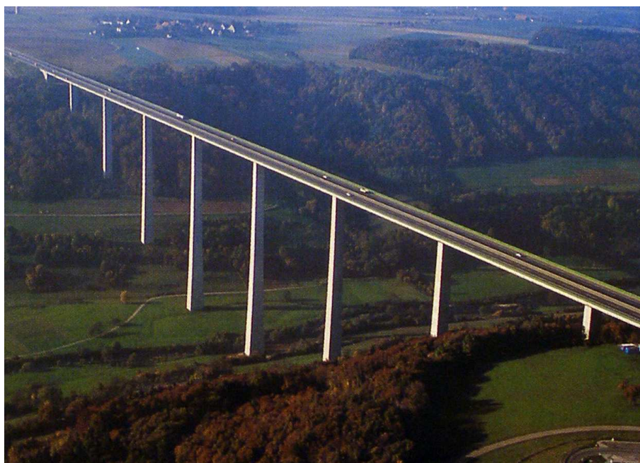
Rys. 9 Most nad doliną Kocher (autostrada Norymberga-Heilbronn), najdłuższy niemiecki wiadukt (185 m nad terenem) - metoda nawisowa wg U. Finslerwaldera
