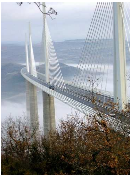
Rys. 7. Grand Viaduc de Millau, architektura Norman Foster, konstrukcja Michel Virlogeux
