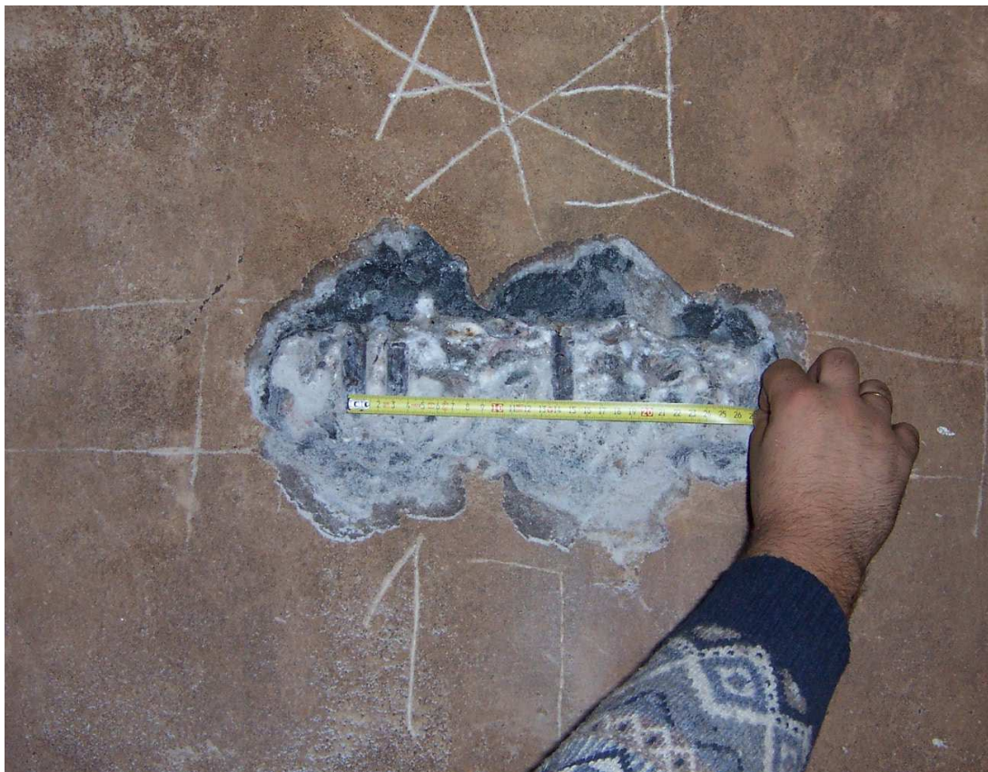
Rys.4. Zbrojenie przy wewnętrznych powierzchniach ścian zbiornika
