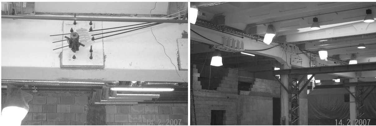
Rys. 12. Ciągnowa konstrukcją odciążająca
