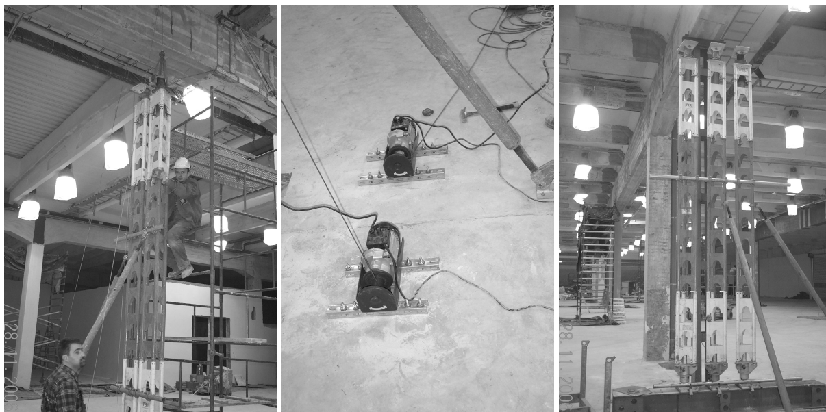
Rys. 8. Montaż podparcia tymczasowego rygla przęsla 18-19F
