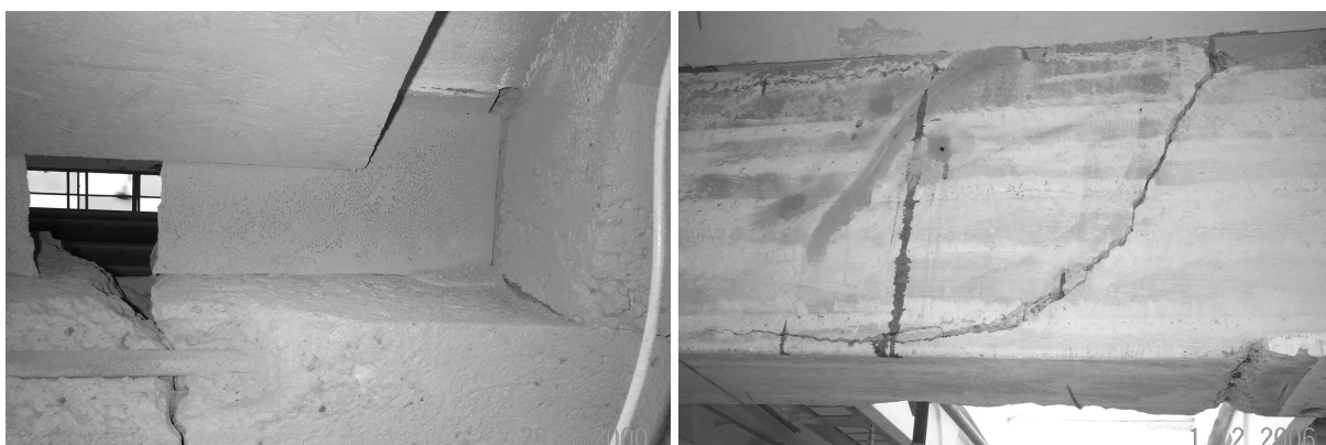
Rys. 2. Złamania rygla B/13-17 i F/17-21 w obszarze przęsłowym
