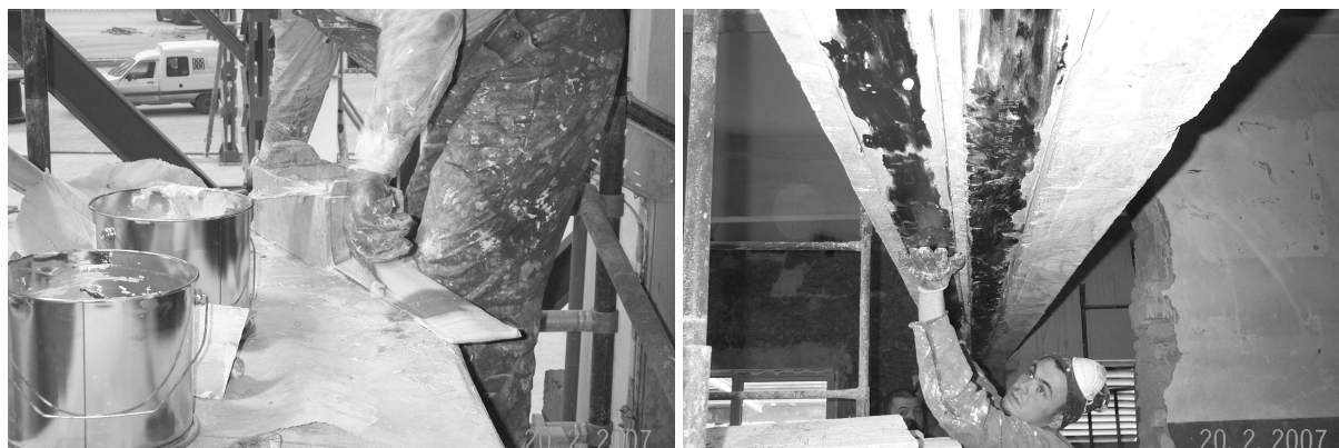
Rys. 10. Aplikacja żywicy na taśmę i taśmy na belkę
