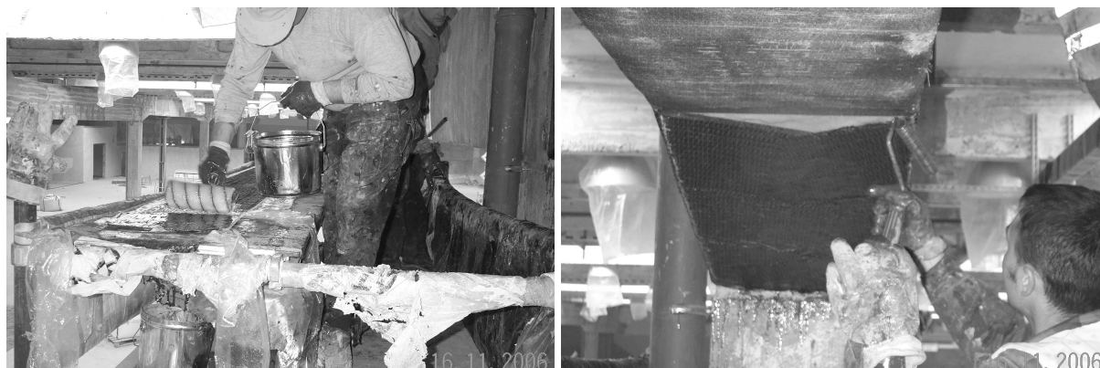
Rys. 11. Aplikacja żywicy RESIN 55 bezpośrednio na tkaninę i wałkowanie na belce
