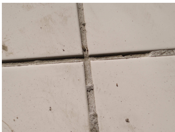
Rys. 11 Wyplukana fuga
