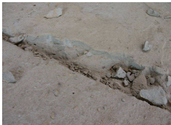
Rys. 4 Przewodniona, krucha szpachlówka
