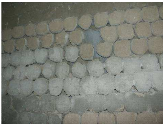
Rys. 7 Brak pełnego przylegania – błędna metoda klejenia
