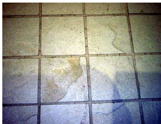
Rys. 12 Spękane fugi
