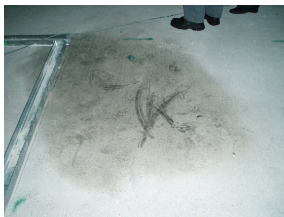
Rys. 2 Zaolejone podłożo
