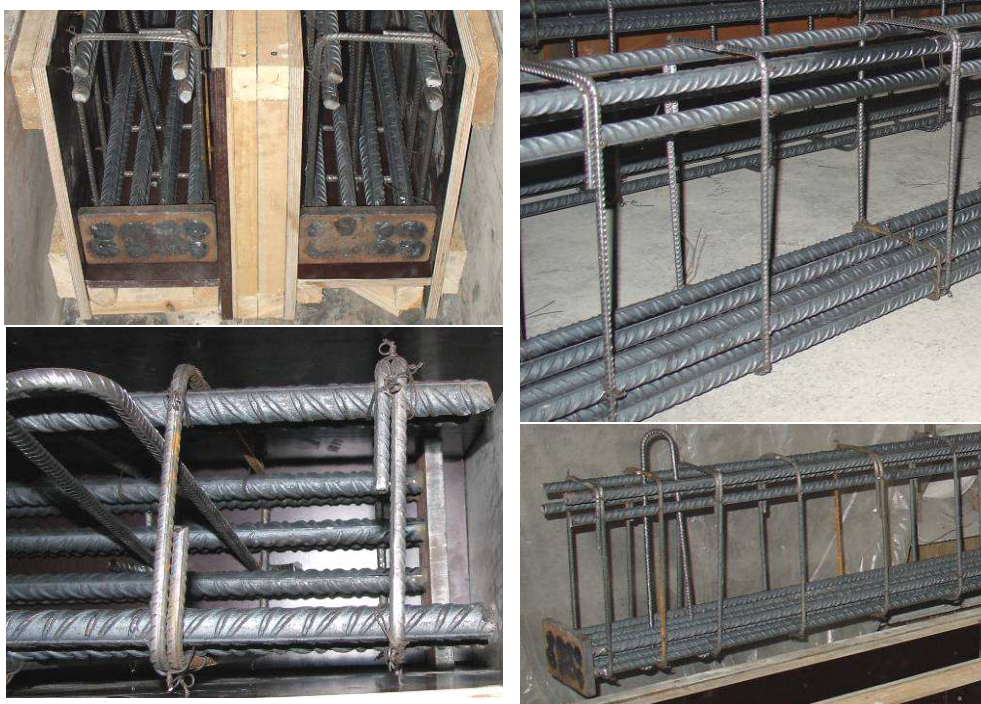
Rys. 3. Szczegóły zbrojenia belek.
