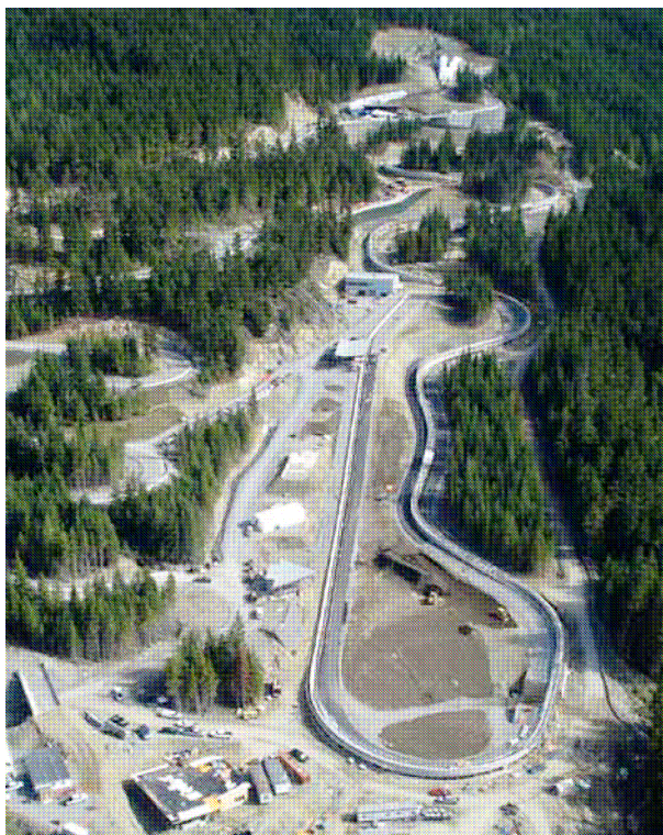
Rys. 3. Budowa toru bobslejowo-saneczkowego w Whistler (Kanada)
