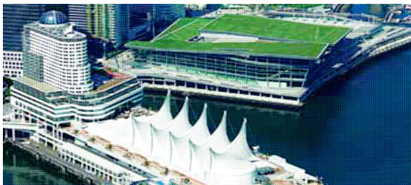
Rys. 4. Centrum Konferencyjne w Vancouver z projektowym okresem użytkowania 100 lat pod „zielonym dachem”
