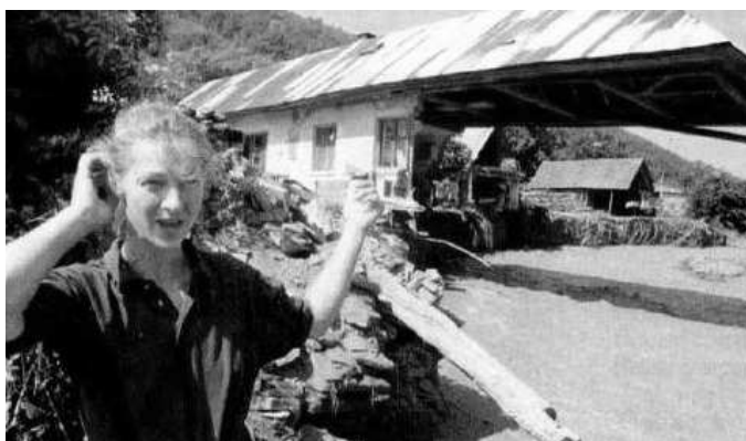
Rys. 3. Wtórny ustrój nośny ukształtowany przez powódź (wtórny ustrój – system konstrukcyjny powstający zastępczo po wystąpieniu lokalnego uszkodzenia jednego elementu nośnego) (fot. Polityka nr 31/1998)
