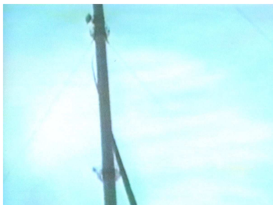
Rys. 11. Kadr z filmu [14] z odciągami od strony czołowej, który wykazuje drgania wywołane zjawiskiem galopowania
