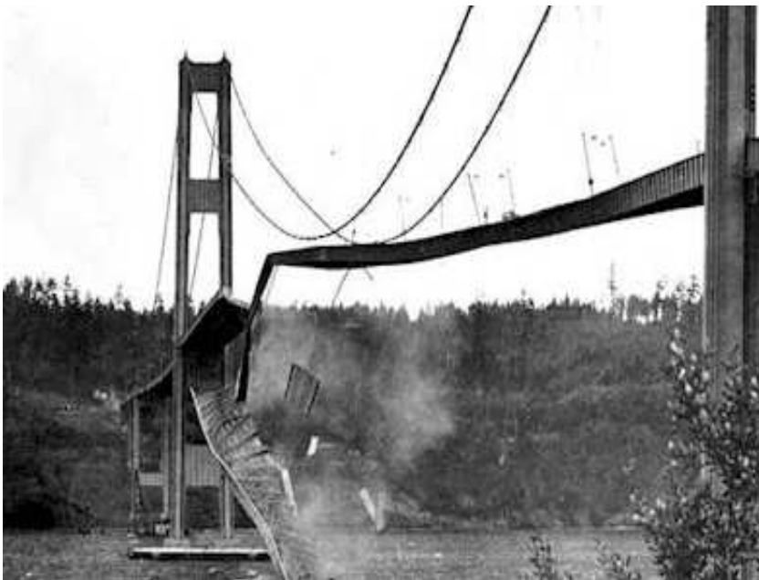
Rys. 2. Zniszczenie przęsła środkowego mostu
