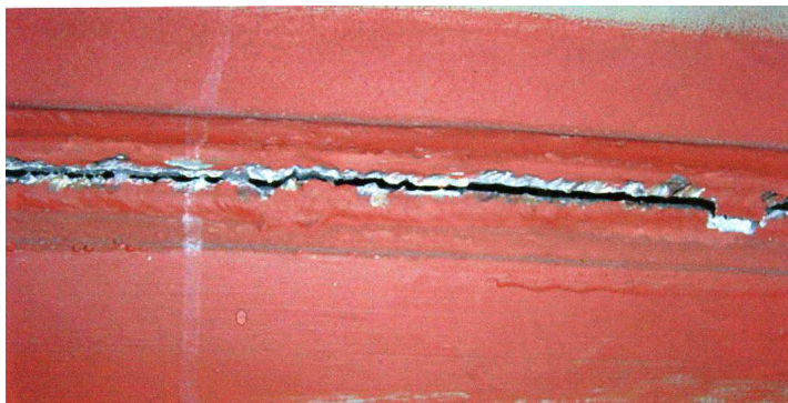
Rys. 5. Połączenie segmentów trzonu komina w poziomie 47,37 m. Widok od wnętrza komina
