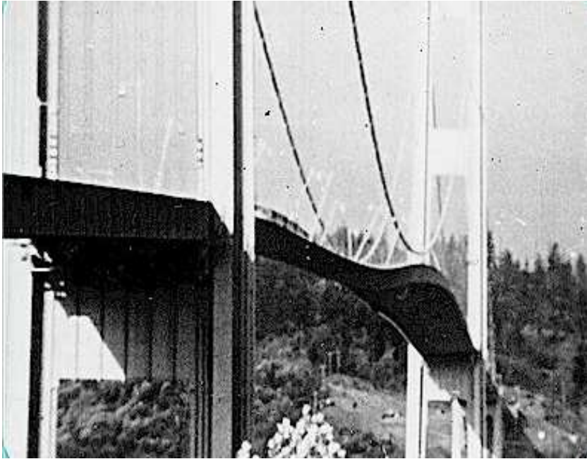
Rys. 1. Drgania skrętne mostu poprzedzające katastrofę
