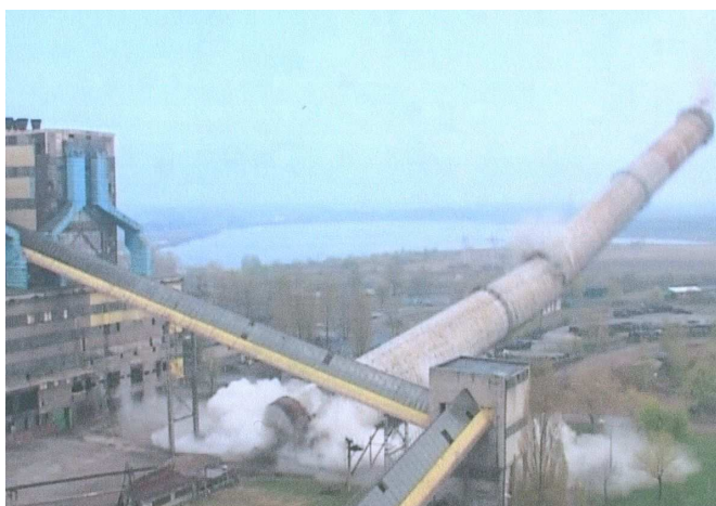
Rys. 13. Usuwanie wyeksploatowanego komina za pomocą materiału wybuchowego. Upadek na przygotowane pryzmy piasku poprzedzony został rozdzieleniem obiektu w połowie jego długości
