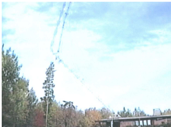
Rys. 10. Kadr z filmu dokumentującego zniszczenie masztu po nagłym zerwaniu dwóch odciągów
