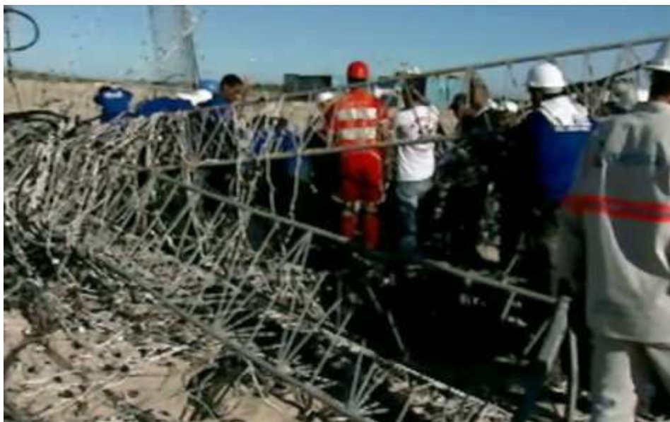
Rys. 10. Katastrofa konstrukcji nośnej choinki z rusztowań, Aracaju, Brazylia, 2008
