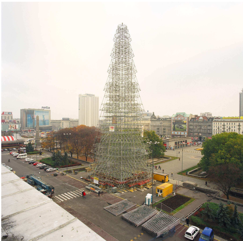
Rys. 9. Konstrukcja nośna choinki z rusztowań, Plac Defilad, Warszawa, 2005 [6]
