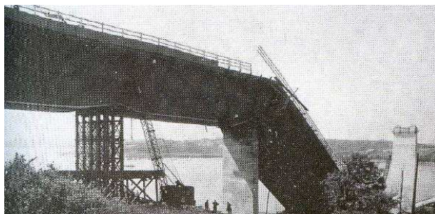
Rys. 23. Most Cleddau po katastrofie [13]
