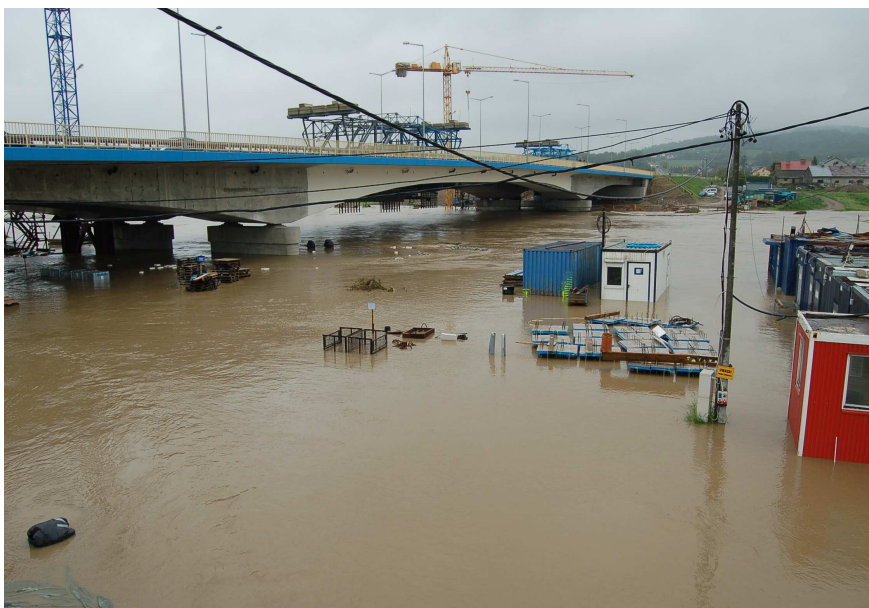
Fot. 9. Przebudowa drogi krajowej nr 4 odc. Machowa - Łańcut
