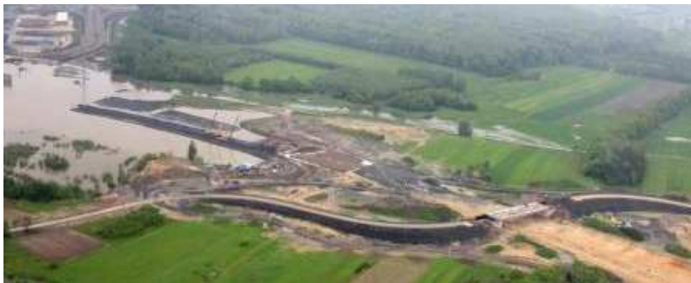
Fot. 1. Budowa A1 od węzła „Sośnica” do węzła „Maciejów”
