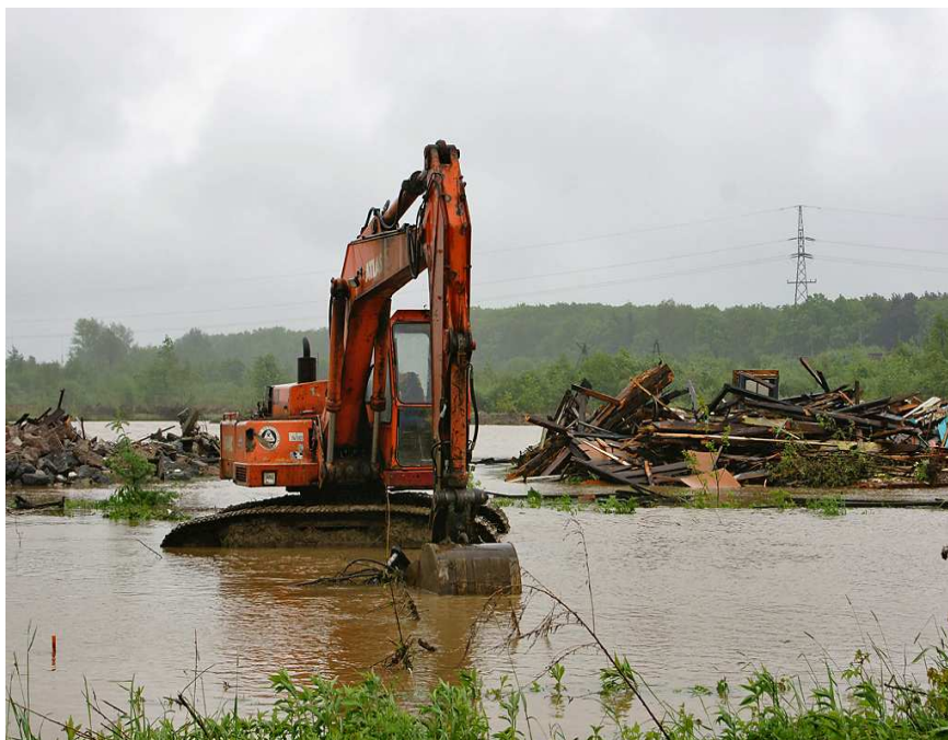
Fot. 13. Budowa Autostrady A-4 odcinek Kraków - Tarnów
