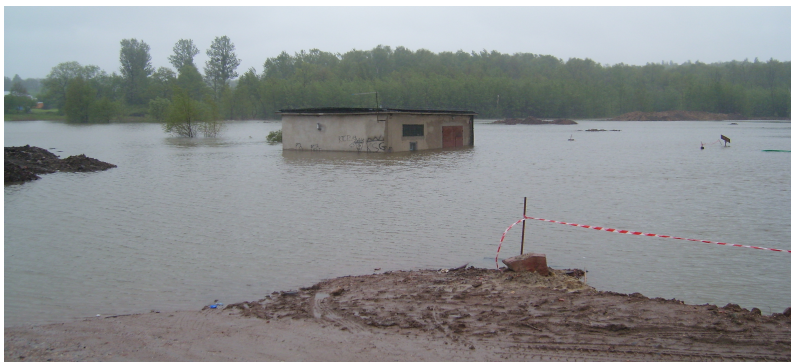
Fot. 11. A1 - Budowa A1 Pyrzowice - Maciejów – Sośnica
