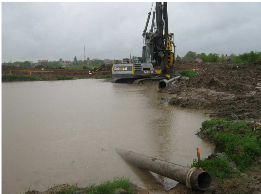
Fot. 12. Budowa A1 Pyrzowice - Maciejów – Sośnica
