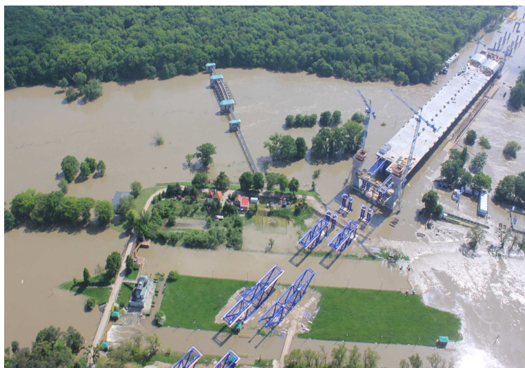
Fot. 7. Budowa obwodnicy Wrocławia A8. Most przez rzekę Odrę wraz z estakadami dojazdowym
