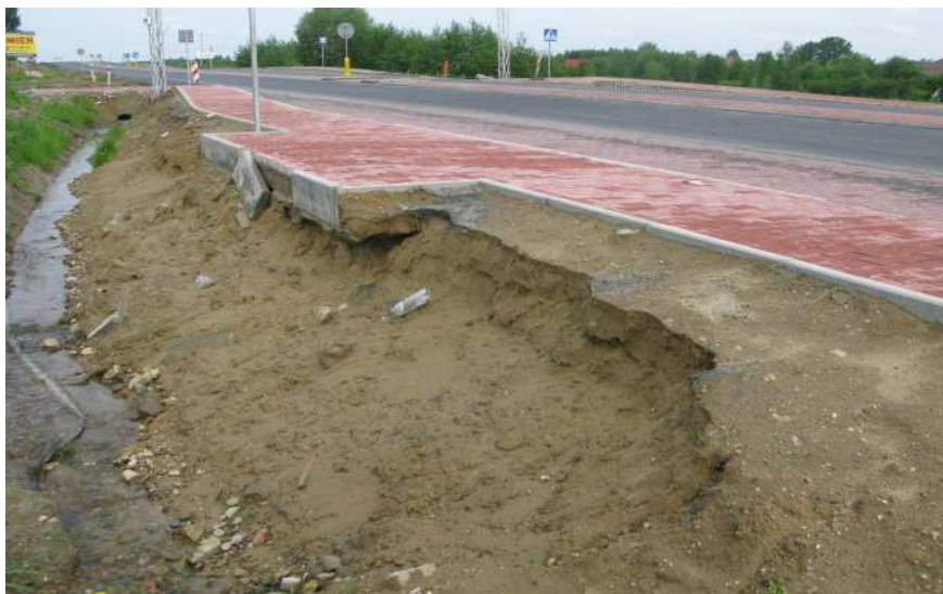
Fot. 8. Przebudowa drogi krajowej nr 4 odc. Machowa - Łańcut
