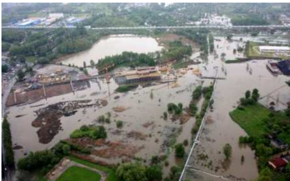
Fot. 5. Budowa A1 od węzła „Sośnica” do węzła „Maciejów” odcinek od km 515+100 do km 515+640 (budowa estakady WA-460)
