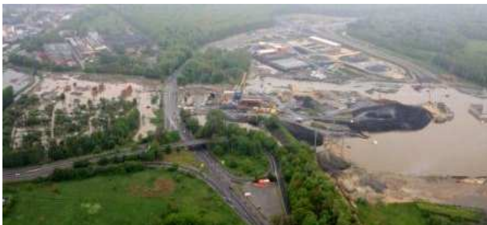
Fot. 3. Budowa A1 od węzła „Sośnica” do węzła „Maciejów” odcinek od km 511+180 do km 512+800 (w tym wiadukt WA-457)
