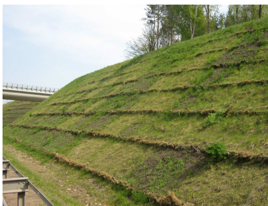
Rys. 20. Przykład zabezpieczenia przed erozją skarpy, faszyna iglasta (nieporastająca) „martwa”
