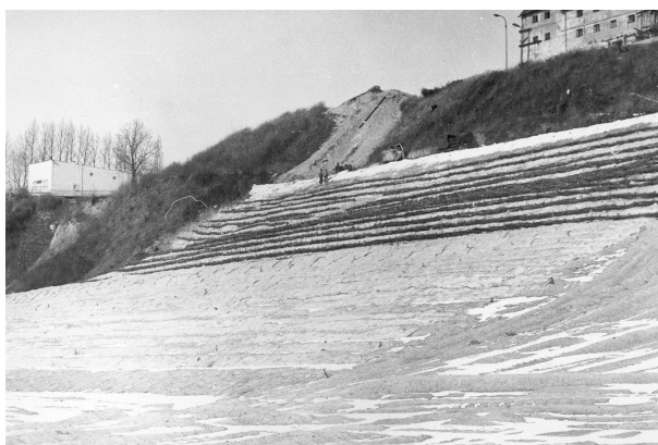
Rys. 22. Przypora z piasku u podnóża skarpy nadbudowywana zabezpieczeniem z udziałem geosyntetyków. Płock - realizacja 1988
