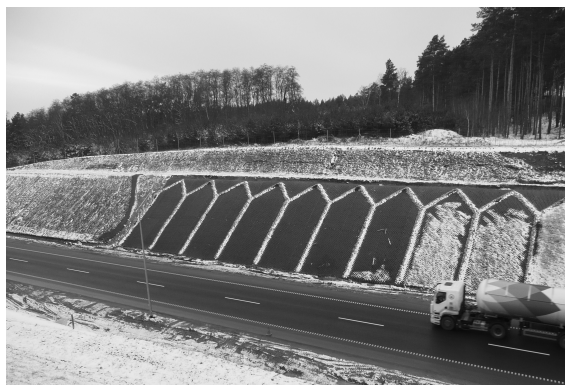
Rys. 21. Przypory drenażowo-przeciwoerozyjne na skarpach wykopów głębokiego przekopu drogowego
