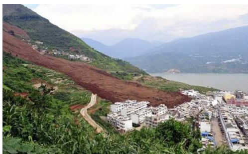
Rys. 1. Zniszczenia domów w Chinach (Hanyuan) przez osuwisko 28.07.2010 [3]
