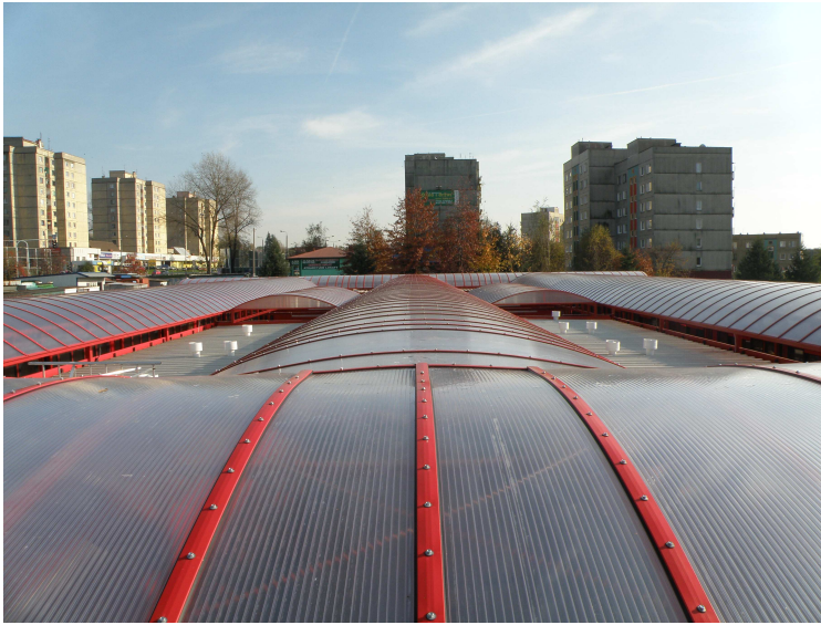
Rys. 4. Widok z góry przekrycia łukowego
