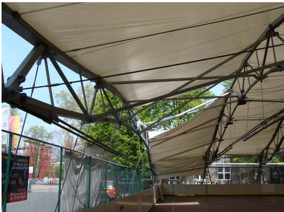
Rys. 7. Skrajne pole przekrycia od strony północnej w trakcie demontażu membrany
