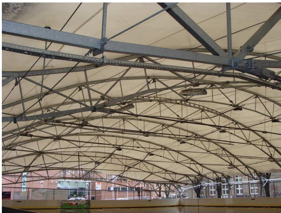
Rys. 3. Widok ogólny dźwigarów kratowych konstrukcji
