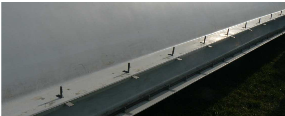
Rys. 5. Widok kołnierza połączeniowego końcowej łupiny w segmencie
