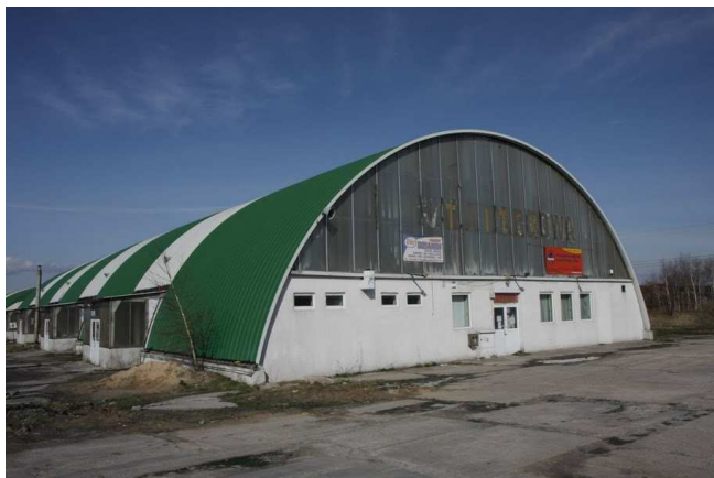
Fot. 1. Hala o przekryciu z samonośnej blachy łukowej
