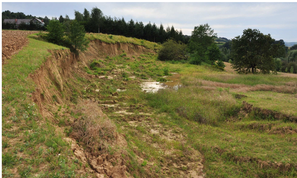
Rys. 3. Początek osuwiska – skarpa o wysokości do 14 m
