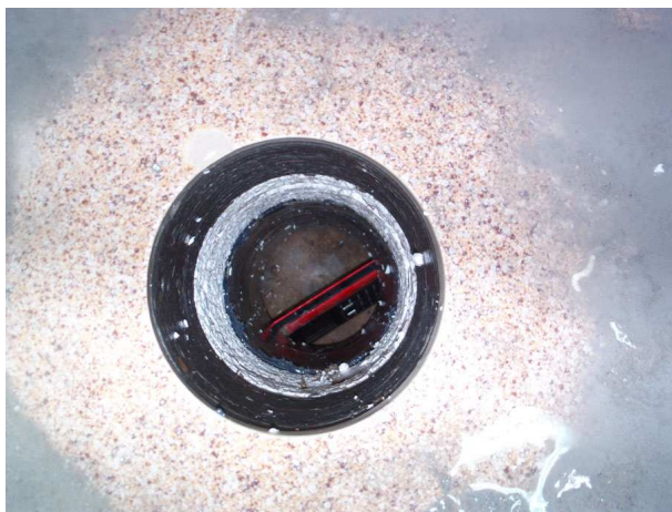
Rys. 4. Szczelina między płytą a podłożem; widoczny umieszczony w niej telefon komórkowy
