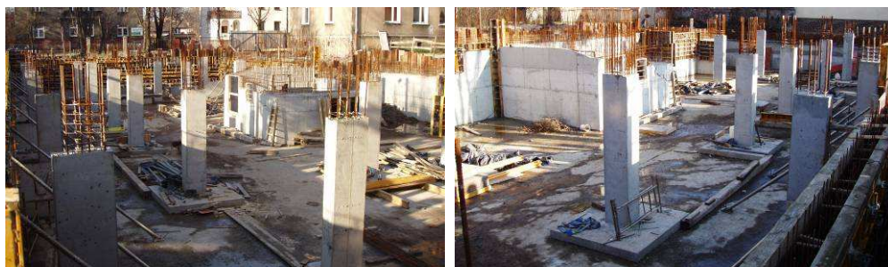
Rys. 5. Stan budowy na wiosnę 2009 r.
