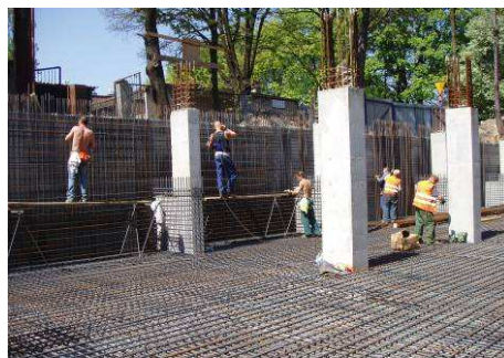
Rys. 6. Żelbetowa wanna – schemat konstrukcji i zbrojenie: 1 – ściana skrzyni, 2 – dobetonowana warstwa, 3 – grodzice ścianki szczelnej
