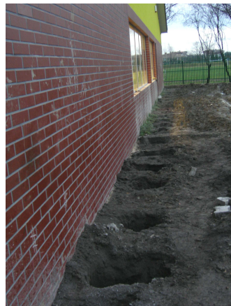
Rys. 6. Podbijanie fundamentów mikropalami
