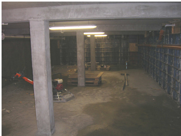
Rys. 5. Wzmacnianie ścian i stropu piwnicy
