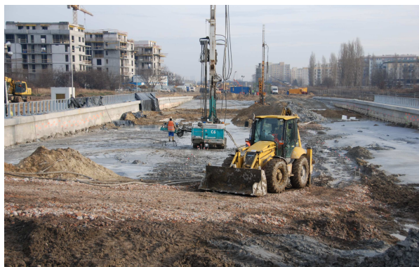
Rys. 2. Przygotowanie platformy roboczej między ścianami szczelinowymi
