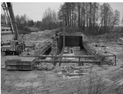
Rys. 8. Podpora nr 2 – betonowanie podpory
