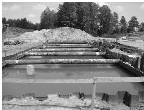
Rys. 6. Wykonany wykop podpora nr 2 wypełniony wodą
