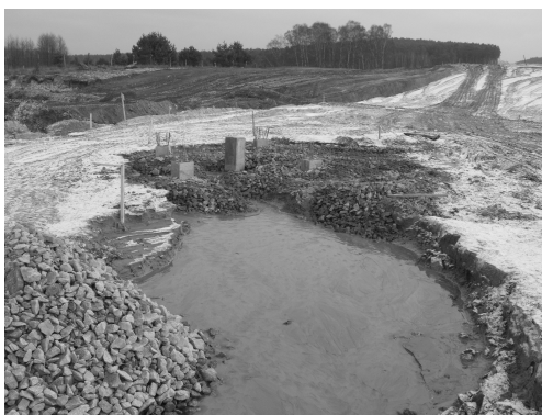
Rys. 5. Wykonane pale testowe z widocznym samowypływem
