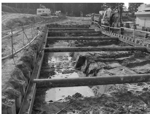
Rys. 7. Wykop po wykonaniu korka cementowego w technologii „jet-grouting”
