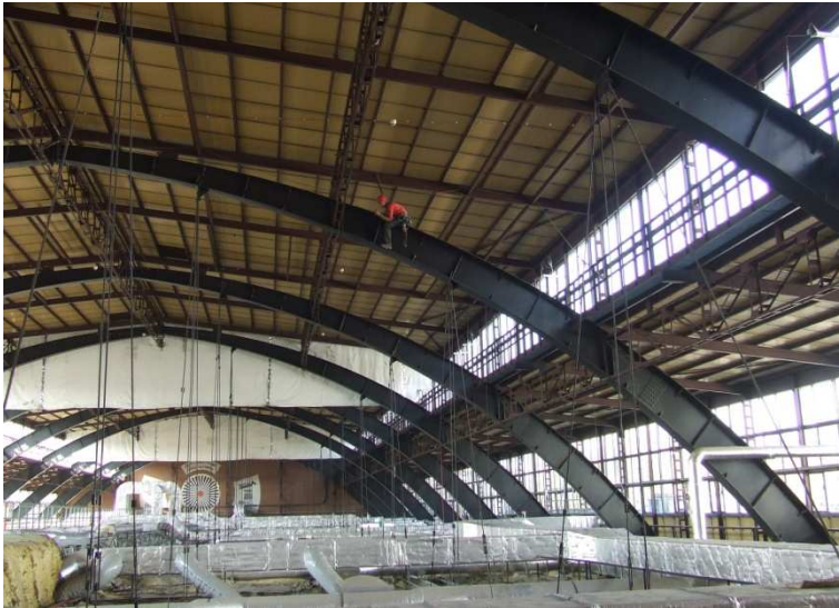
Rys. 4. Przestrzeń hali powyżej sufitów pomieszczeń handlowych (2010 r.)
