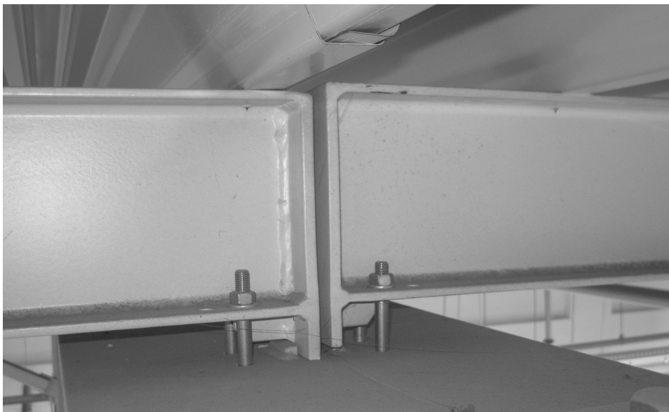
Rys. 6. Oparcie typowej płatwi IPE180 na pasie górnym dwuteowego rygla ramy
