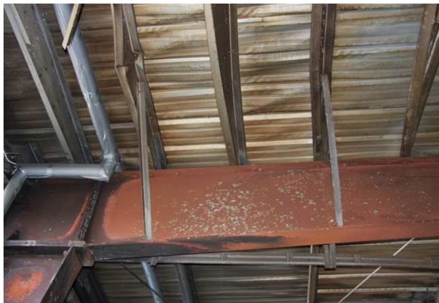
Rys. 8. Widok osmolonego połączenia dźwigara ze słupem
