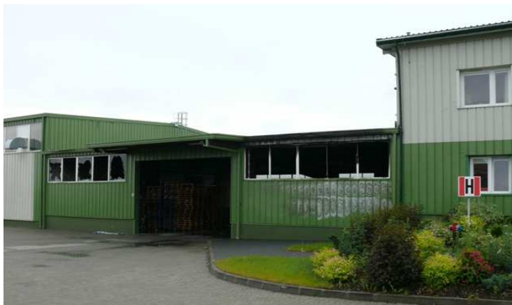
Rys. 1. Widok rozważanej hali po pożarze (hala w osiach systemowych 8–11 – patrz rys. 2)
