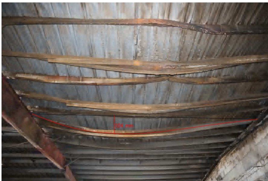
Rys. 4. Ugięcia płatwi dachowych z zaznaczoną maksymalną strzałką
