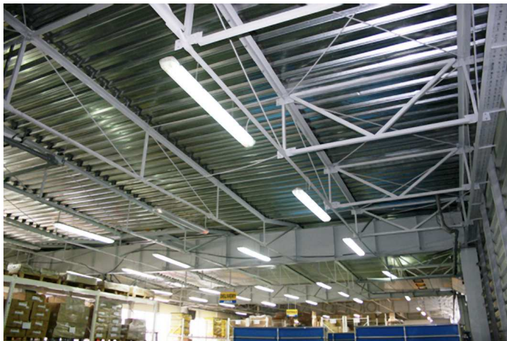
Rys. 2. Widok konstrukcji dachowej od wnętrza obiektu
