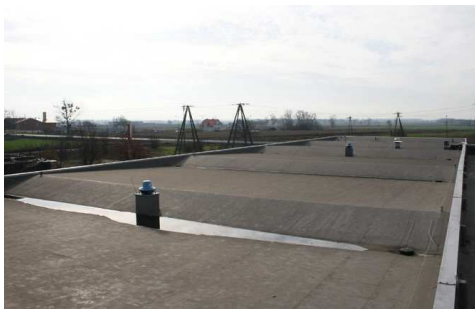
Rys. 7. Zastoiny wody na dachu segmentu jednonawowego
