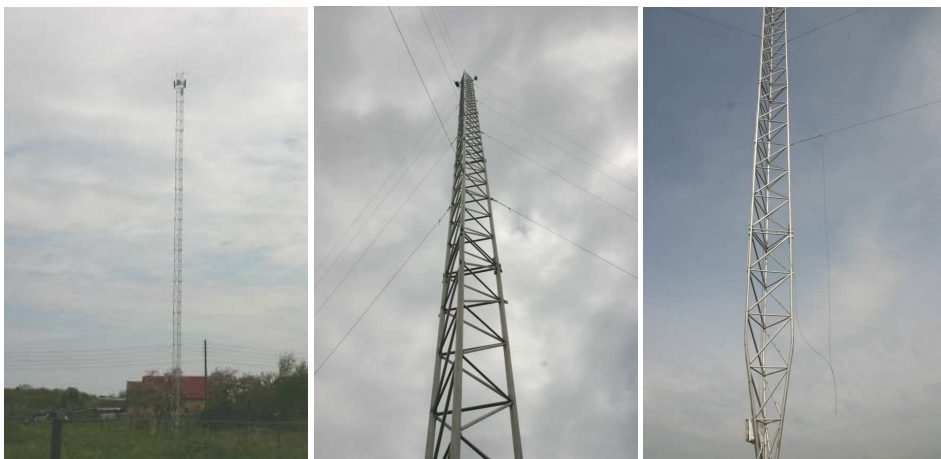
Rys 1. Widok trzech aluminiowych masztów antenowych – A i B o H = 24,0 m, maszt C o H = 40,0 m
