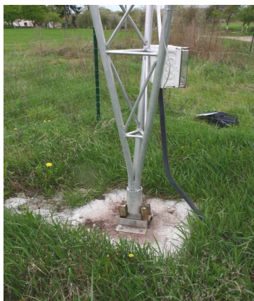
Rys. 5. Oparcie trzonu masztu H = 24,0 m na stopie fundamentowej
