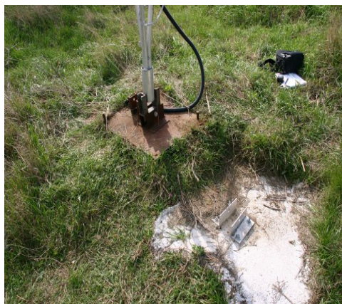
Rys. 6. Aktualne i projektowane oparcie masztu C o H = 40,0 m
