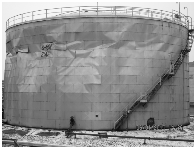
Rys. 1. Widok ogólny zbiornika
