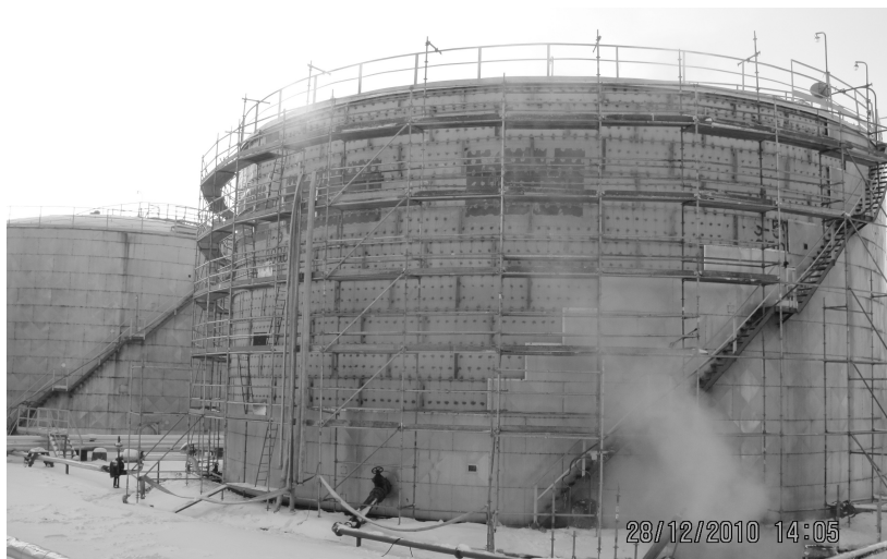
Rys. 9. Naprawiony zbiornik przed zamontowaniem izolacji
