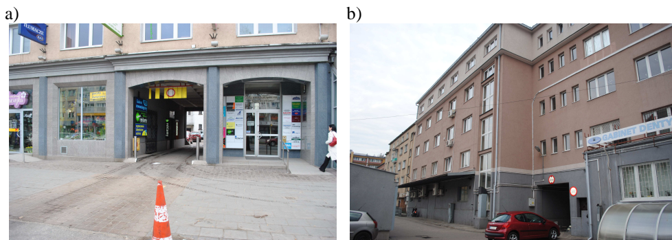
Rys. 1. Widok przejazdu: a) od strony ulicy, b) od strony zaplecza budynku
