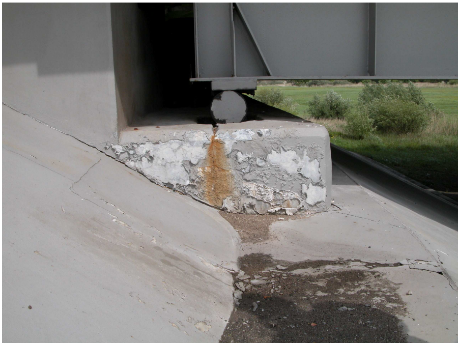
Rys. 4. Powłoka na betonie – rzeczywistość. Powłoka ułożona na przyczółku zasypnym gruntem i na umocnieniu skarpy z betonu
