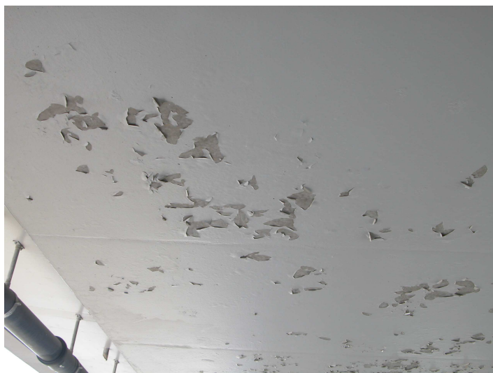
Rys. 2. Powłoka na betonie – rzeczywistość. Między warstwą gruntującą a warstwą nawierzchniową powłoki osadził się węglan wapna powodując odspojenie warstwy nawierzchniowej
